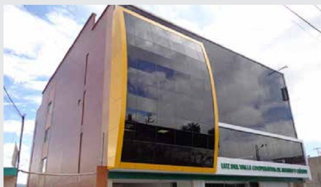
Imagen de la nueva instalación de la Cooperativa Luz del Valle
